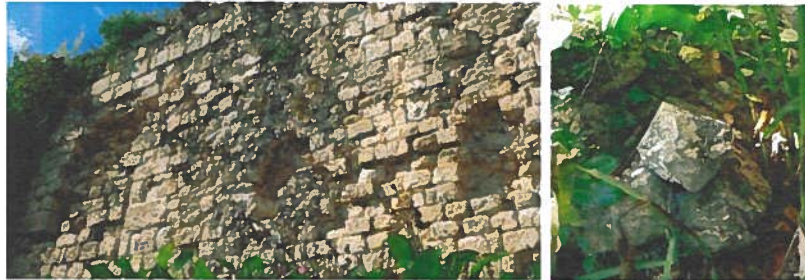
Eboulements ponctuels relativement profonds. Pierres tombées toujours au pied de mur.
