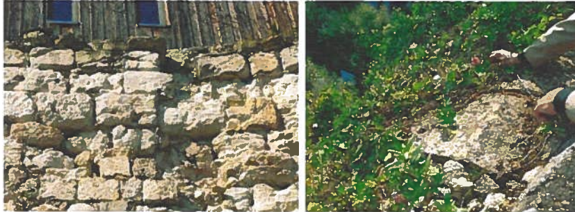
Glacis PDT (3) vestige du parapet de la plateforme d'artillerie du XVIème ?
